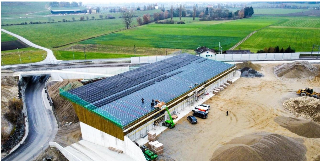
Von oben: Montage der neuen Photovoltaikanlage. Der Sonnenstrom wird vor Ort genutzt.
